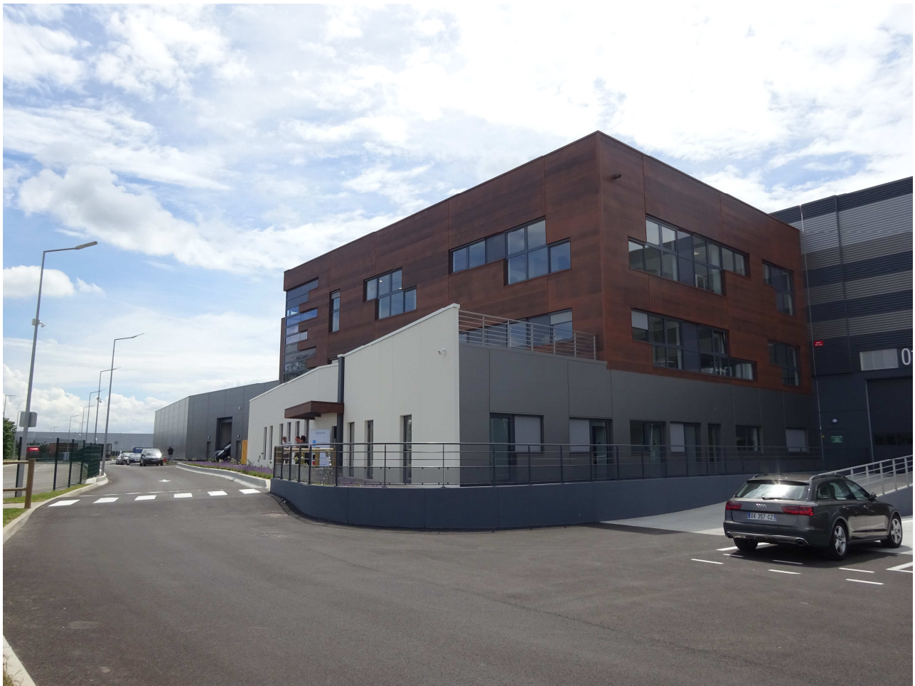
Détail du Volume Bureaux / Locaux Sociaux du bâtiment VAILOG à Saint-Quentin-Fallavier (38) (S.A.R.L. d'architecture ARCHI-FACTORY)
